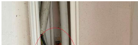
Durchgescheuerter Isolierungen von Kabeln im Kabelkanal
