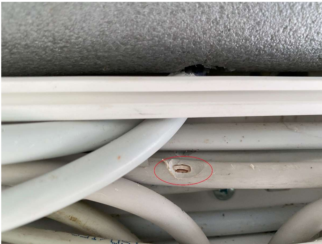
Durchgescheuerter Isolierungen von Kabeln im Kabelkanal
